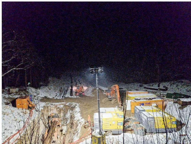
Auch in Kroatien sind die Tage im Winter kurz. Zur Ausleuchtung der Baustelle wurde daher ein Atlas-Copco-Lichtmast des Typs Highlite B5+ verwendet. Im Vordergrund die gelben Drill-Air-Kompressoren, die mit Dieselmotoren der Abgasstufe V arbeiten. (Bild: Petzold)
