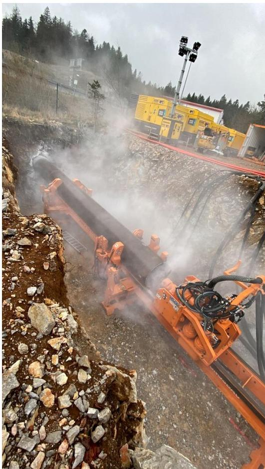
*Die Druckluft aus den Atlas-Copco-Kompressoren (im Hintergrund) treibt den Schlagkolben des Imlochhammers im Inneren des Hammerbohrgeräts (groß im Bild) an, wodurch der Bohrkopf der Maschine auf die Bohrlochsohle schlägt. Durch die Schläge tritt am Kopf Luft aus, die zugleich die Sohle reinigt und das gelöste Bohrgut über den Ringraum der Maschine nach hinten und zurück an die Erdoberfläche spült. (Bild: Petzold)*
