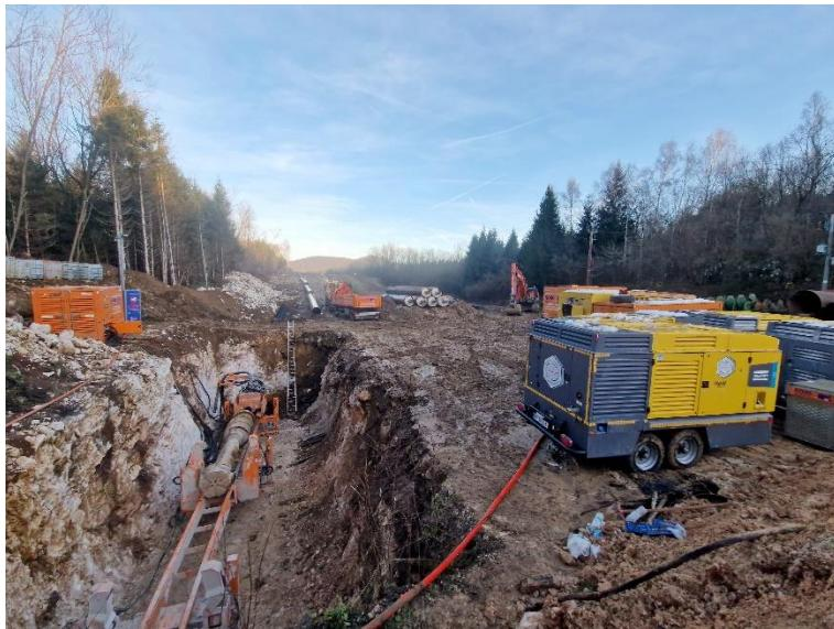
*Bei der zweiten Baustelle in Kroatien, im Januar 2025 in Bosiljevo, war der Fels noch härter als bei der ersten. Damit wurde für das Hammerbohrgerät auch mehr Druckluft benötigt – hier bereitgestellt von fünf Atlas-Copco-Drill-Air-Kompressoren. Die lieferten zusammen etwa 150 Kubikmeter Druckluft pro Minute. (Bild: Petzold)*
