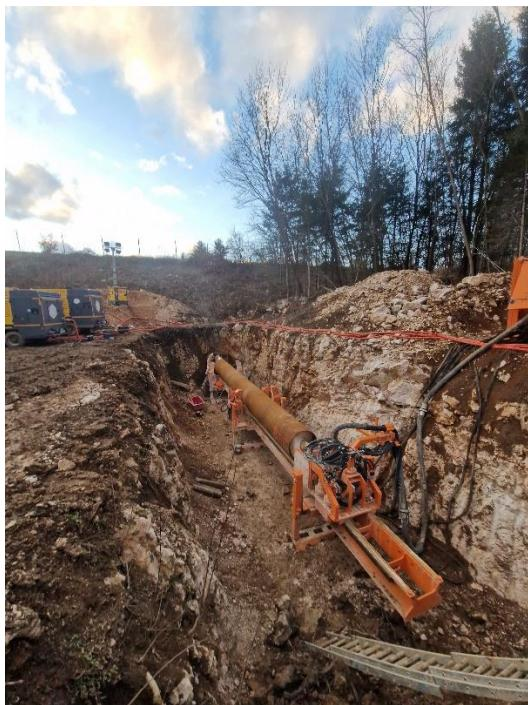
*Das Hammerbohrgerät HZR 1200 ist nach Aussage des finnischen Herstellers Geonex das derzeit größte und stärkste seiner Art. Damit ließen sich die Bohrungen für Gas-Pipelines in Kroatien zuverlässig durchführen. (Bild: Petzold)*
