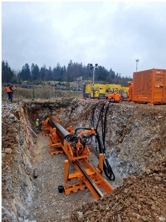
*Die erste von zwei Bohrungs-Baustellen in Kroatien, hier bei Lučice, war gut 107 Meter lang und hatte einen Durchmesser von einem Meter. Der Untergrund wechselt ständig zwischen Fels, Lehm, Geröll und aufgeschüttetem Boden und stellt damit hohe Anforderungen an die Bohrtechnik. Die zunächst von einem einheimischen Unternehmen eingesetzte Schneckenbohrmaschine blieb stecken, der Bohrkopf verhakte sich und riss ab. Aus Deutschland kam dann Abhilfe. (Bild: Petzold)*
